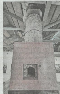
Chimenea de la conservera Barreras.
